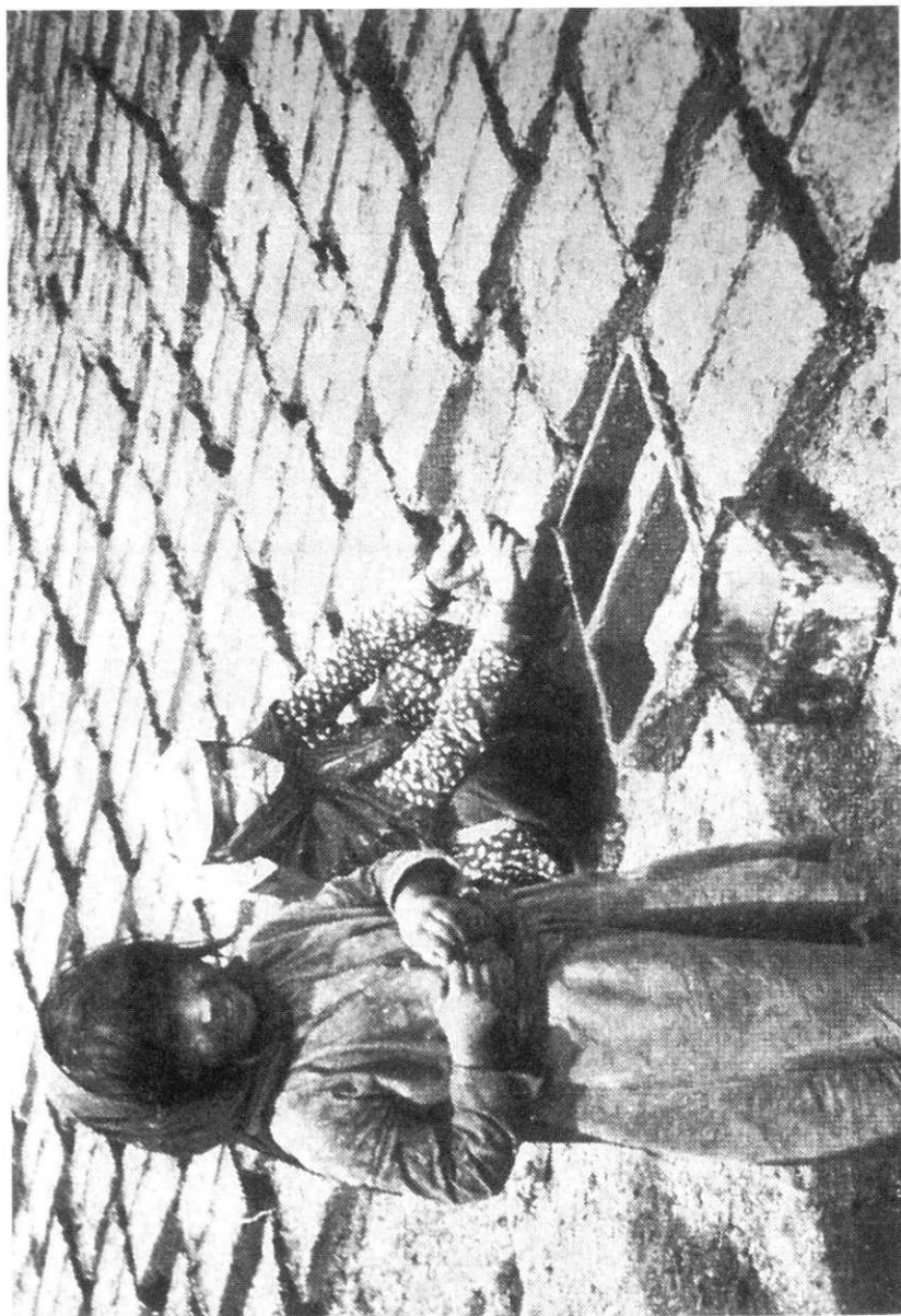
Abb. 9: Lehmziegelherstellung mit dem Formrahmen [Lloyd 1981, 150]
